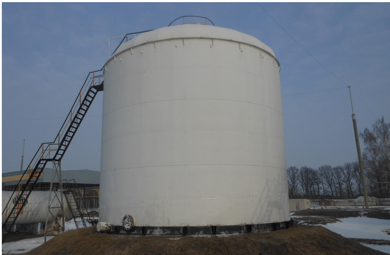
Рисунок 1 – Общий вид резервуара стального вертикального цилиндрического РВС-700
