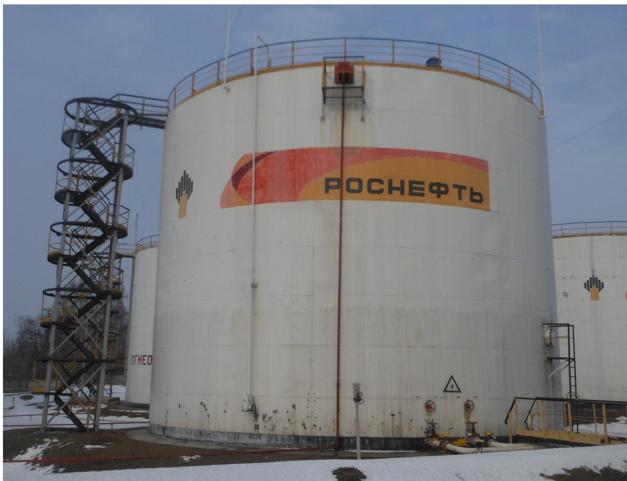
Рисунок 1 – Общий вид резервуара стального вертикального цилиндрического РВСП-2000
