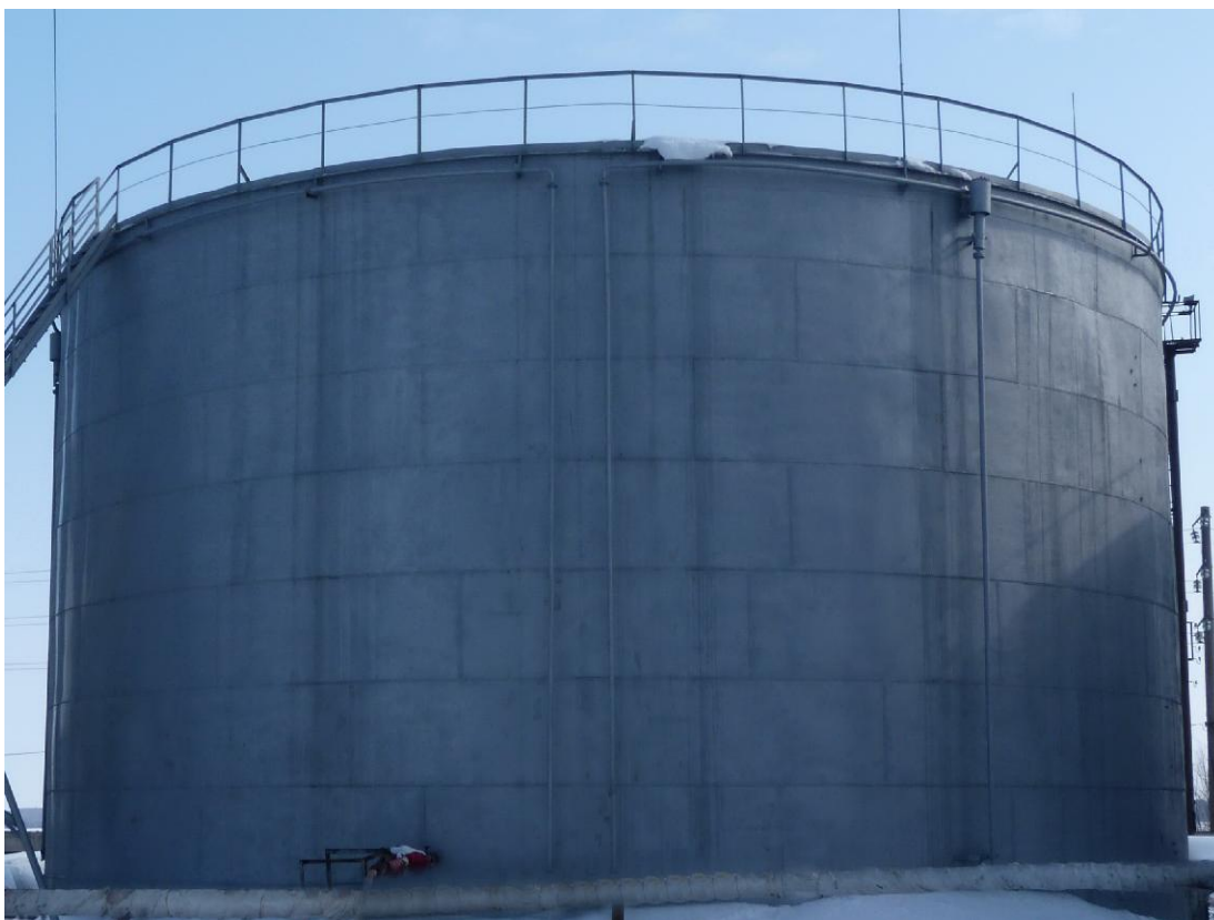
Рисунок 2 – Общий вид резервуара стального вертикального цилиндрического РВС-4000
