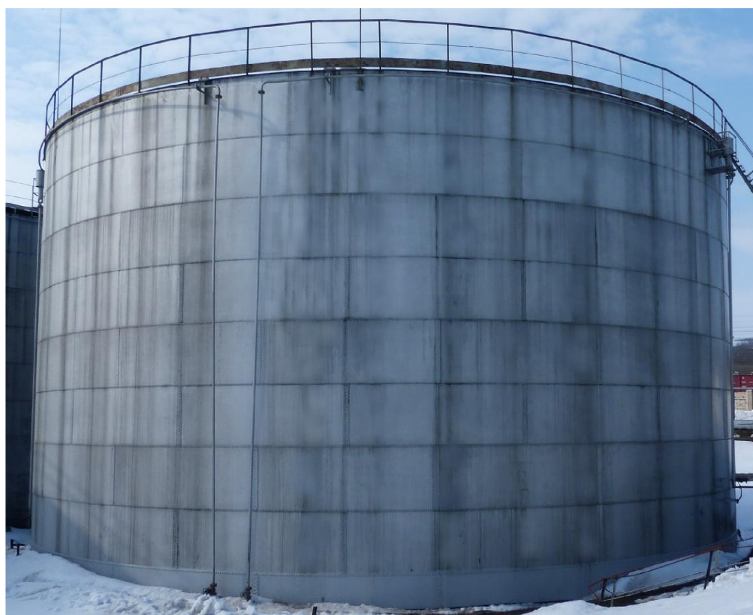
Рисунок 3 – Общий вид резервуара стального вертикального цилиндрического РВС-5000
