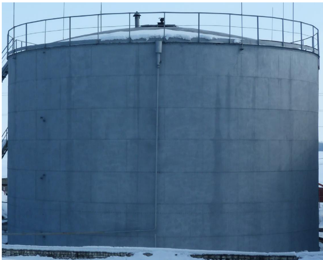
Рисунок 1 – Общий вид резервуара стального вертикального цилиндрического РВС-3000
