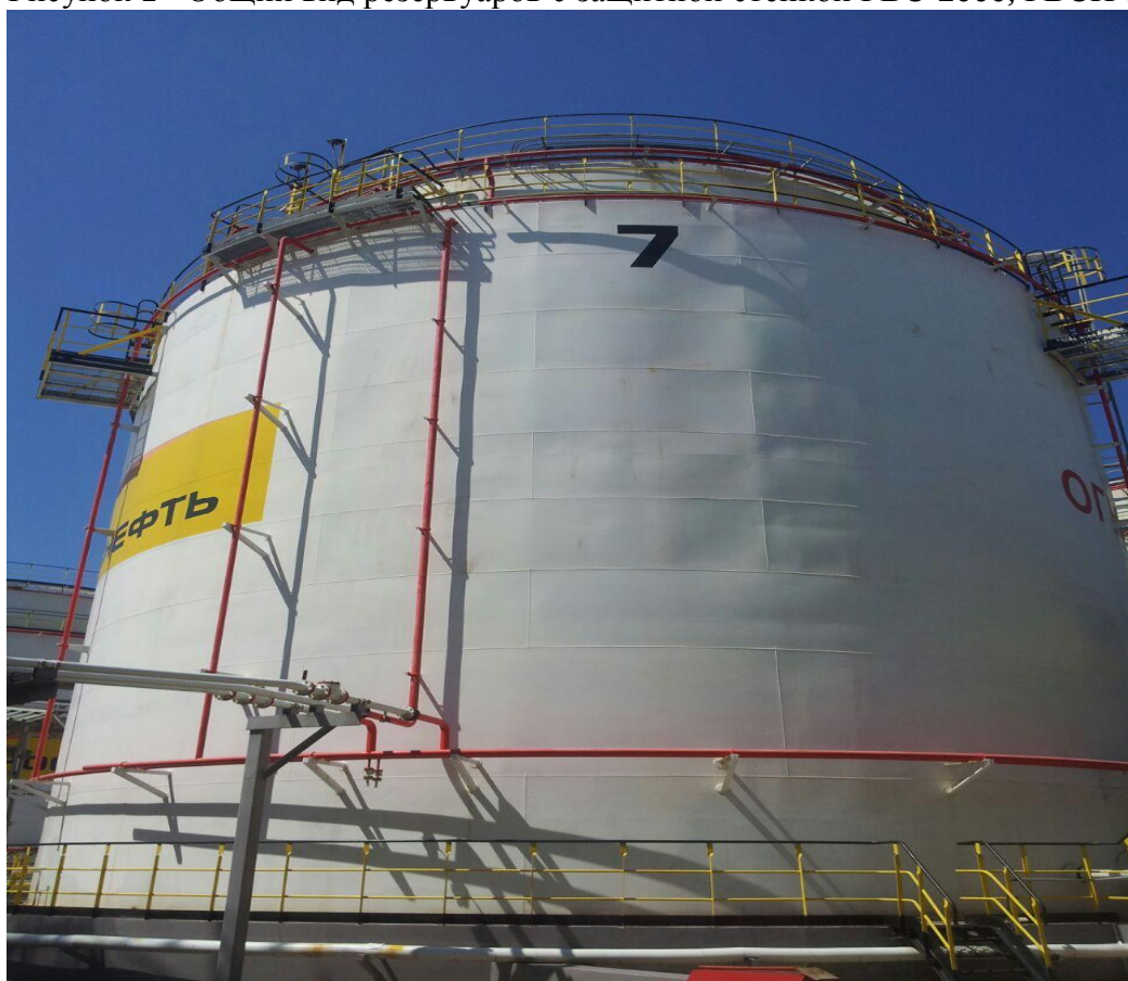
Рисунок 2 - Общий вид резервуара с защитной стенкой РВСП-3000
