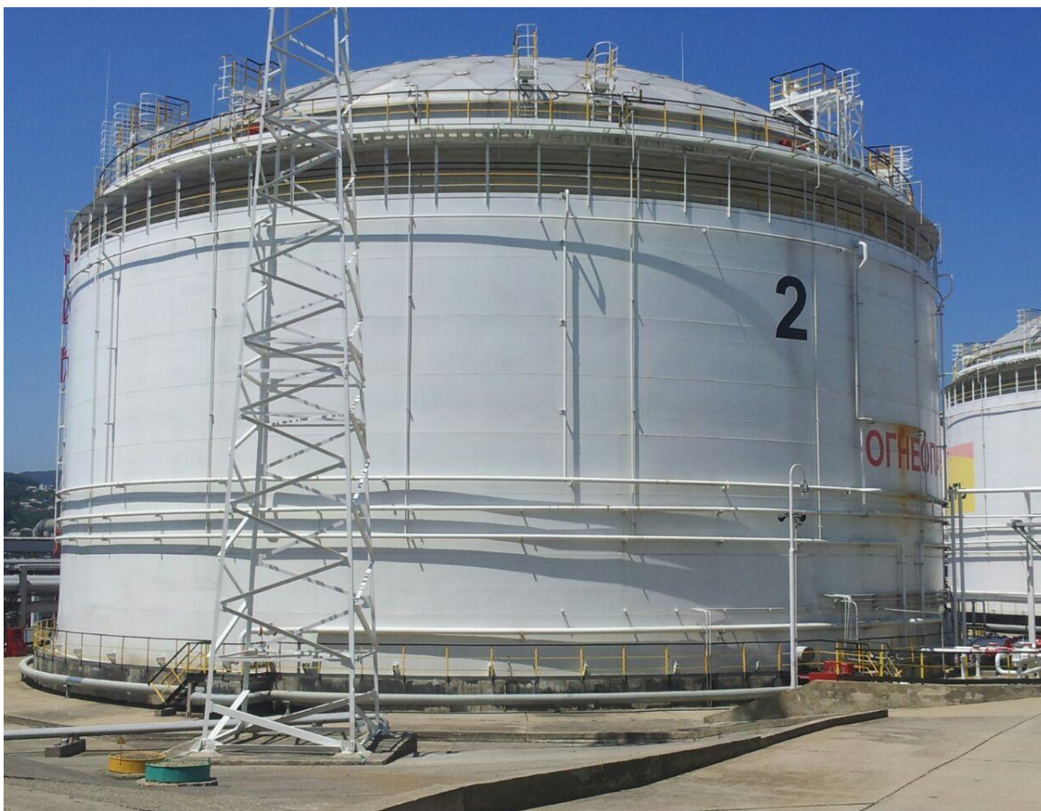
Рисунок 1 - Общий вид резервуаров с защитной стенкой РВСП-20000
