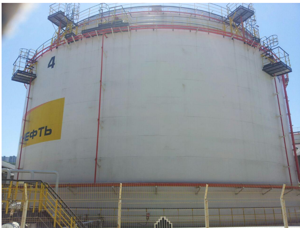
Рисунок 1 - Общий вид резервуаров с защитной стенкой РВС-5000
