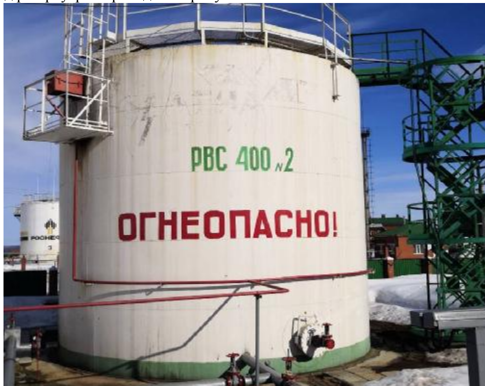
Рисунок 1 - Общий вид резервуара РВС-400
