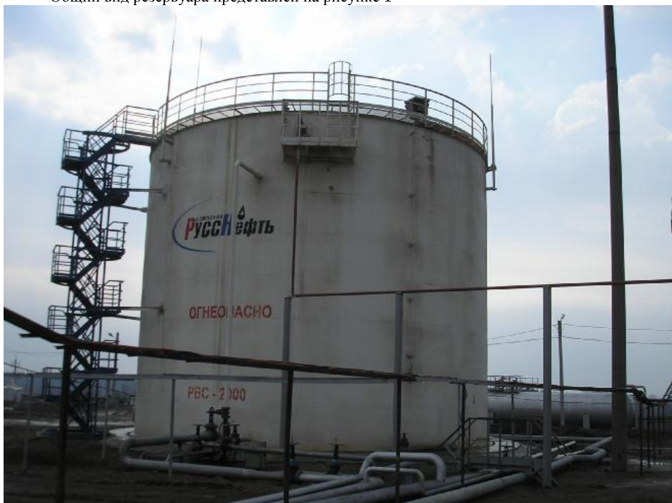
Рисунок 1 - Резервуар вертикальный стальной РВС-2000
