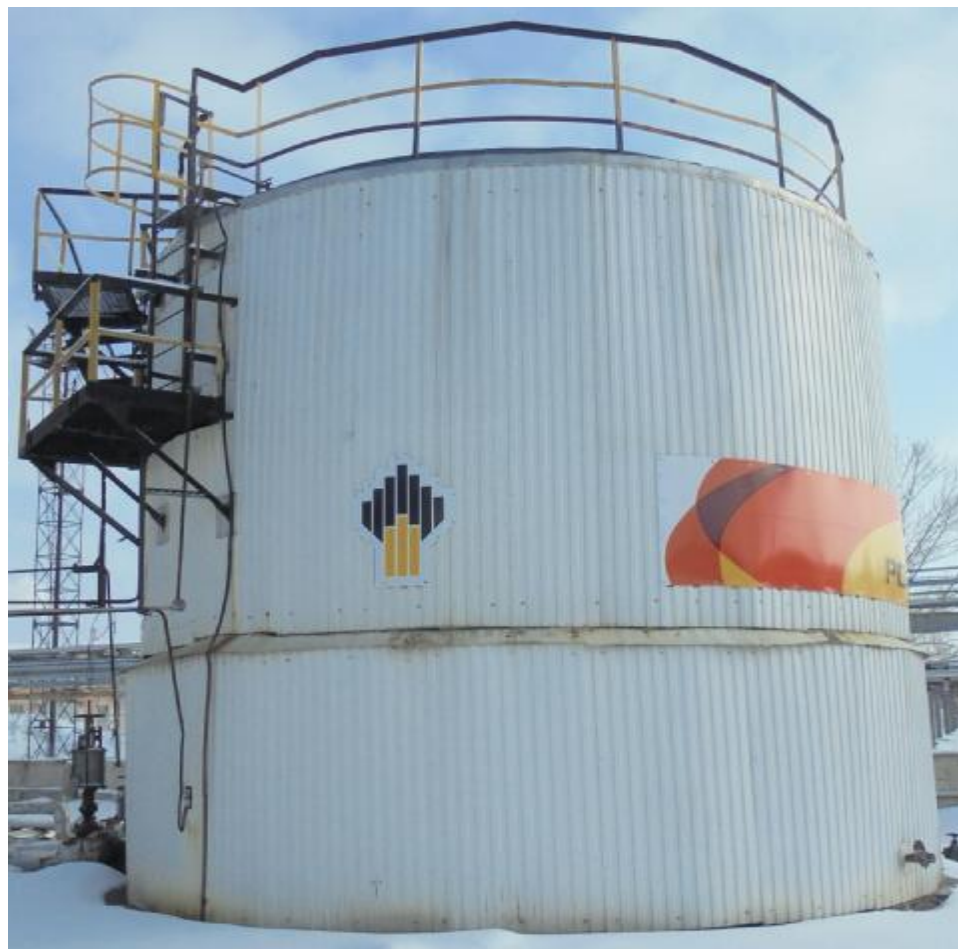
Рисунок 1 – Общий вид резервуара стального вертикального цилиндрического РВС-200
