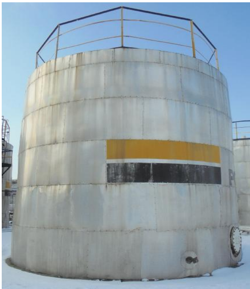
Рисунок 1 – Общий вид резервуара стального вертикального цилиндрического РВС-200
