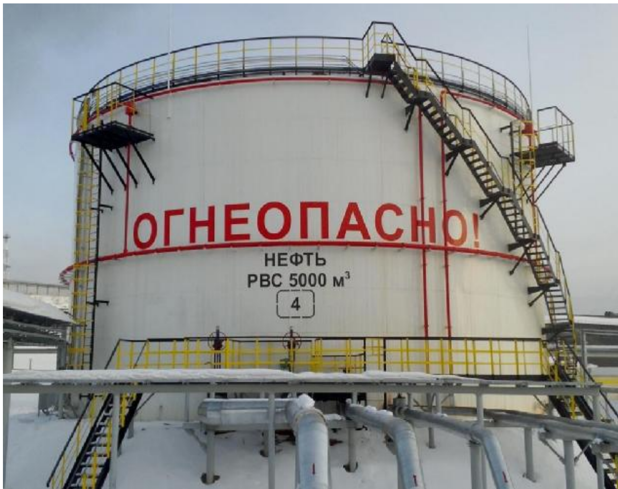
Рисунок 1 – Общий вид резервуара стального вертикального цилиндрического РВС-5000
