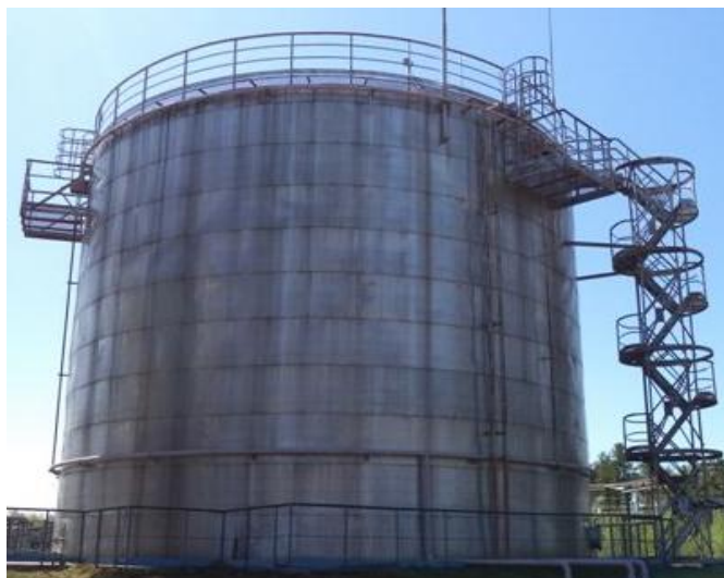
Рисунок 1 – Общий вид резервуара
