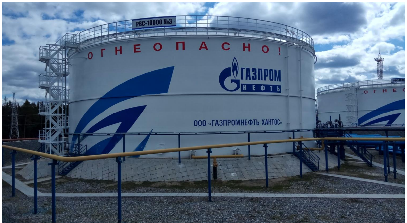
Рисунок 1 - Общий вид резервуара РВС-10000
