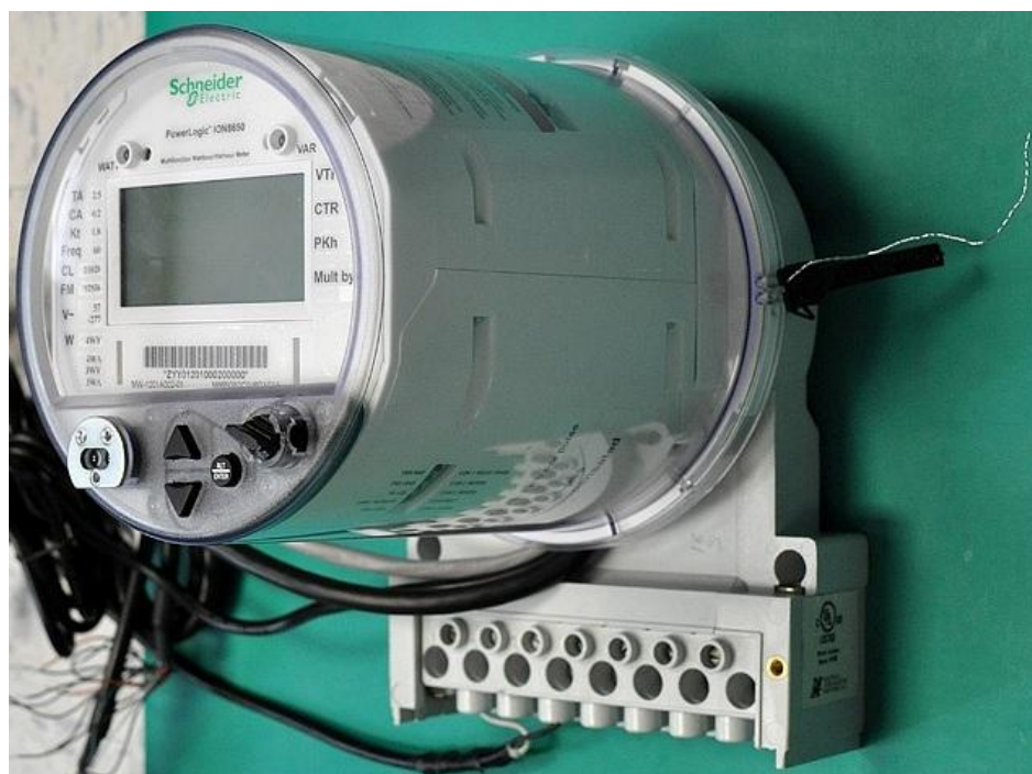
Рис. 2. Место пломбирования гнездового корпуса счётчика ION8650
