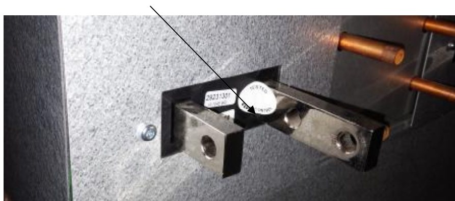
Рисунок 2 - Места опломбирования ИК модулей
