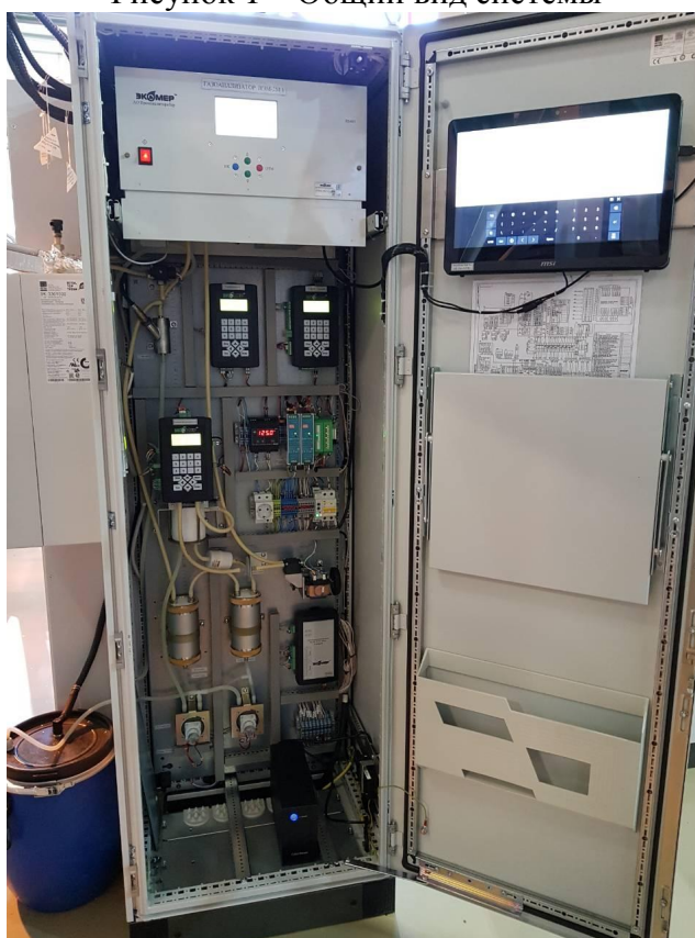
Рисунок 2 – Вид внутри шкафа газоаналитической части системы
