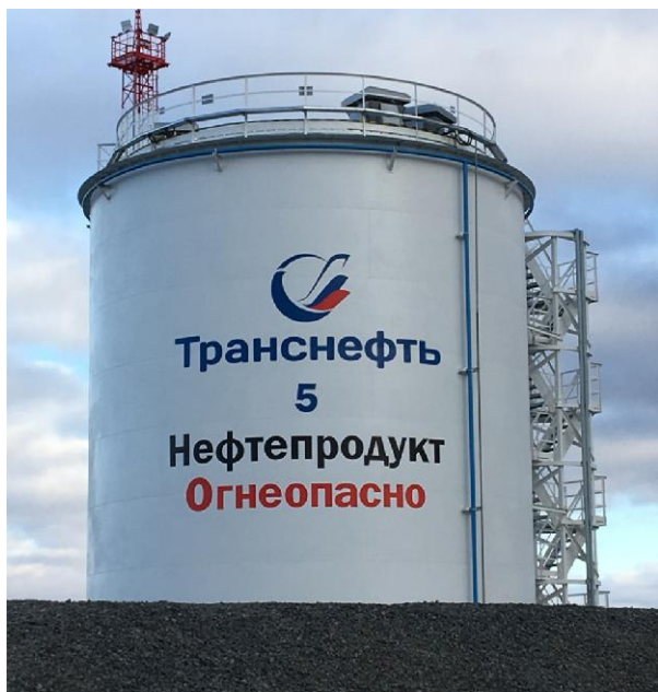
Рисунок 1 - Общий вид резервуаров стальных вертикальных цилиндрических РВС-1000 зав. №№ 5, 6
