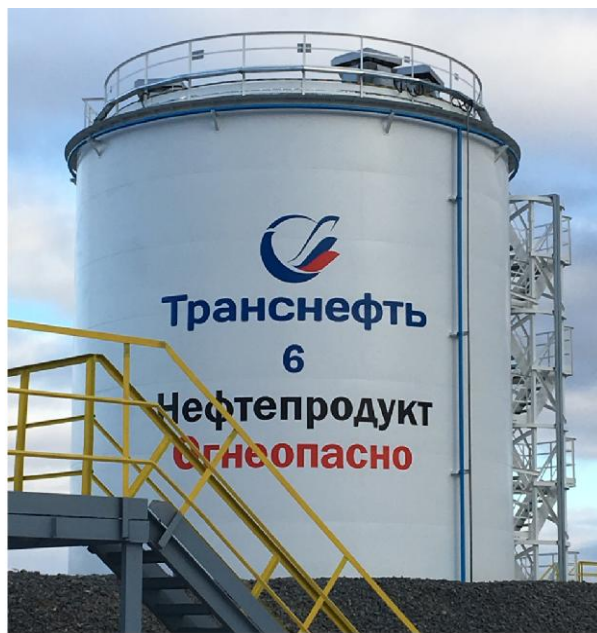
Рисунок 1 - Общий вид резервуаров стальных вертикальных цилиндрических РВС-1000 зав. №№ 5, 6
