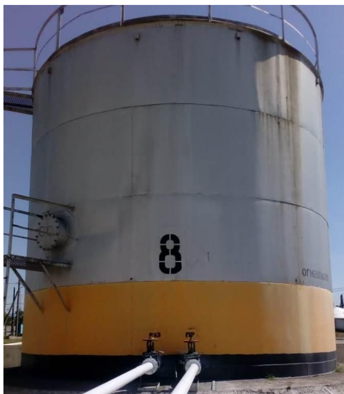
Рисунок 1 - Общий вид резервуара стального вертикального цилиндрического РВС-200
