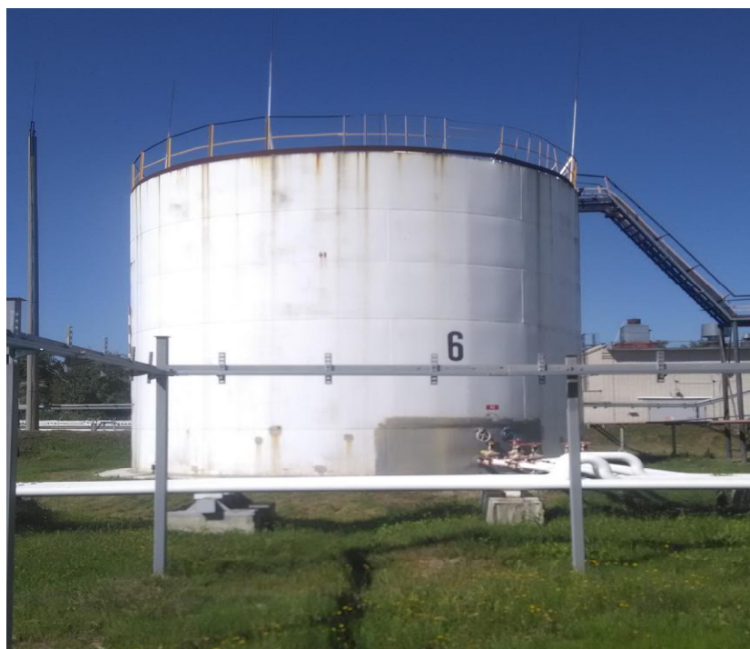
Рисунок 1 - Общий вид резервуара
