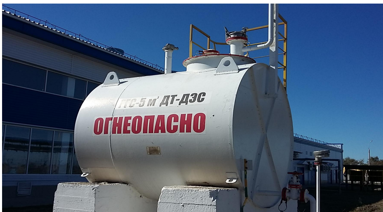
Рисунок 1 - Общий вид резервуара РГС-5 №108
