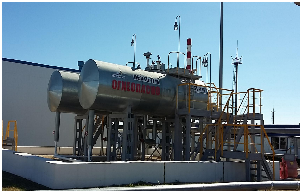
Рисунок 2 - Общий вид резервуаров РГС-20 №№ 171, 180
