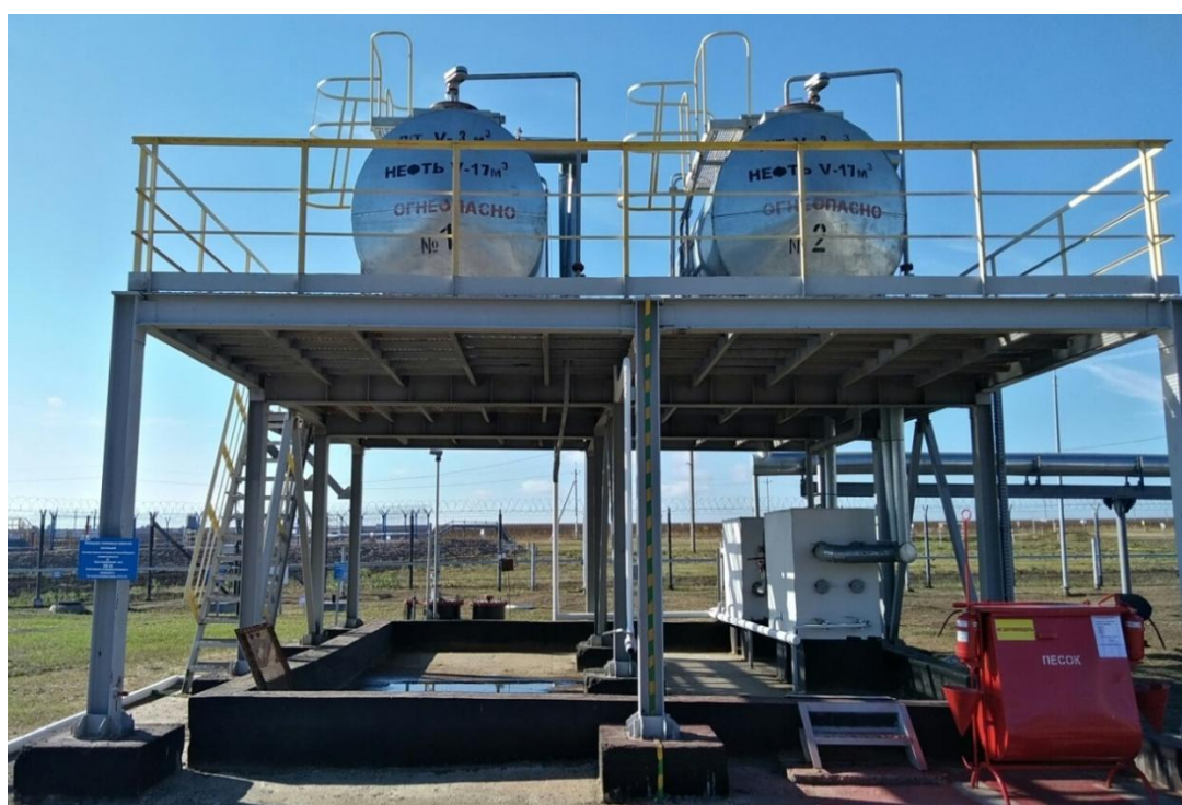
Рисунок 4 - Общий вид резервуаров №№ 220, 221
