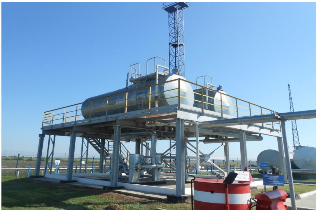
Рисунок 5 - Общий вид резервуаров №№ 226, 227
