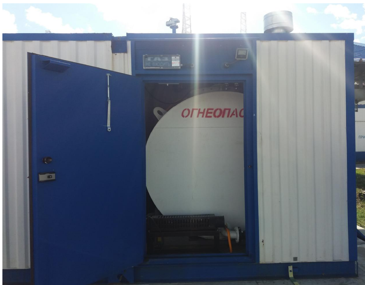
Рисунок 3 - Общий вид резервуара №3
