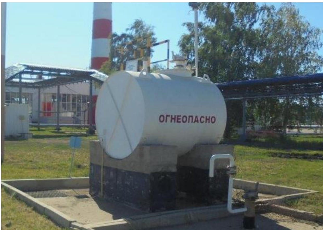
Рисунок 2 - Общий вид резервуара № 2
