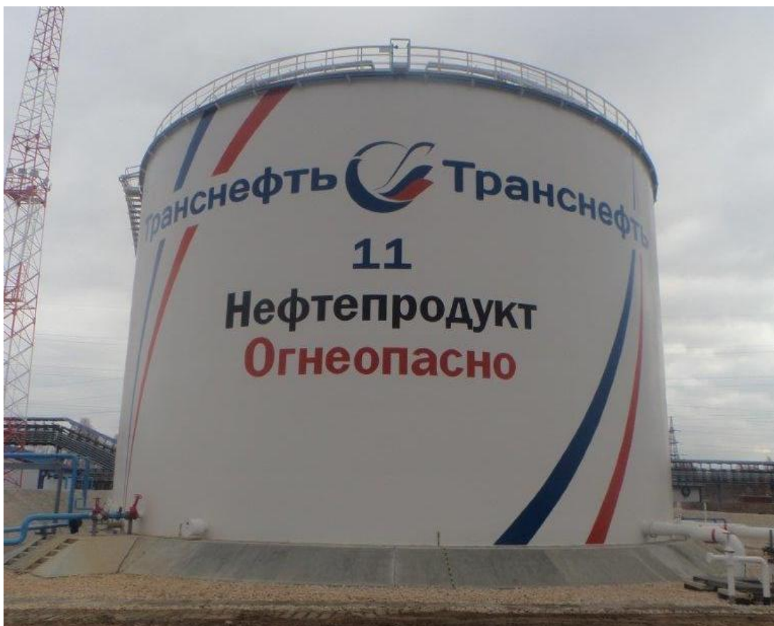
Рисунок 1 - Общий вид резервуара вертикального стального цилиндрического РВС-10000
