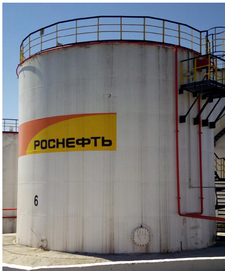
Рисунок 1 - Общий вид резервуара стального вертикального цилиндрического РВС-700
