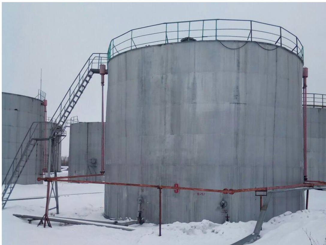
Рисунок 1 - Общий вид резервуара вертикального стального цилиндрического РВС-700
