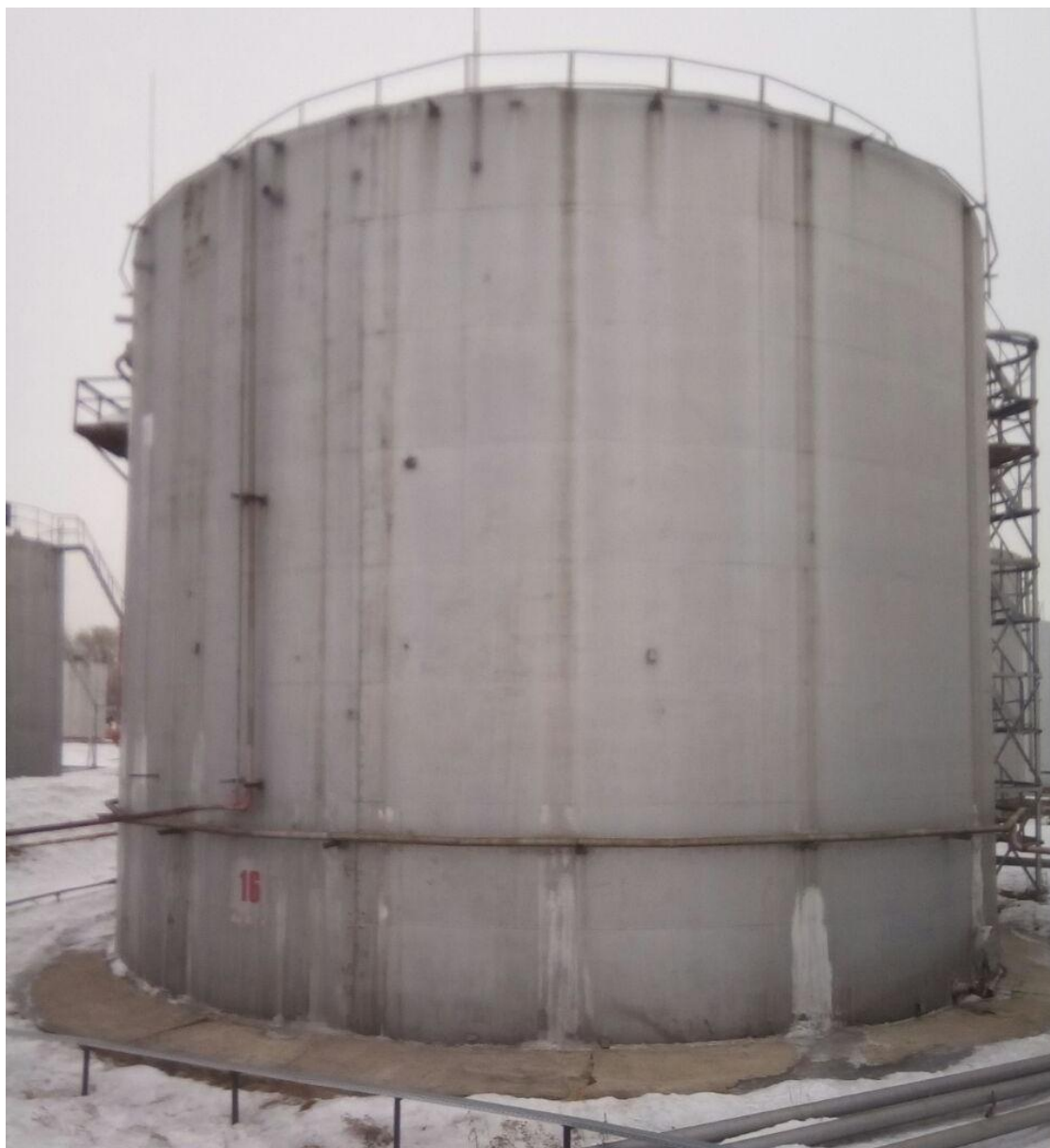
Рисунок 2 - Общий вид резервуара вертикального стального цилиндрического РВС-2000
