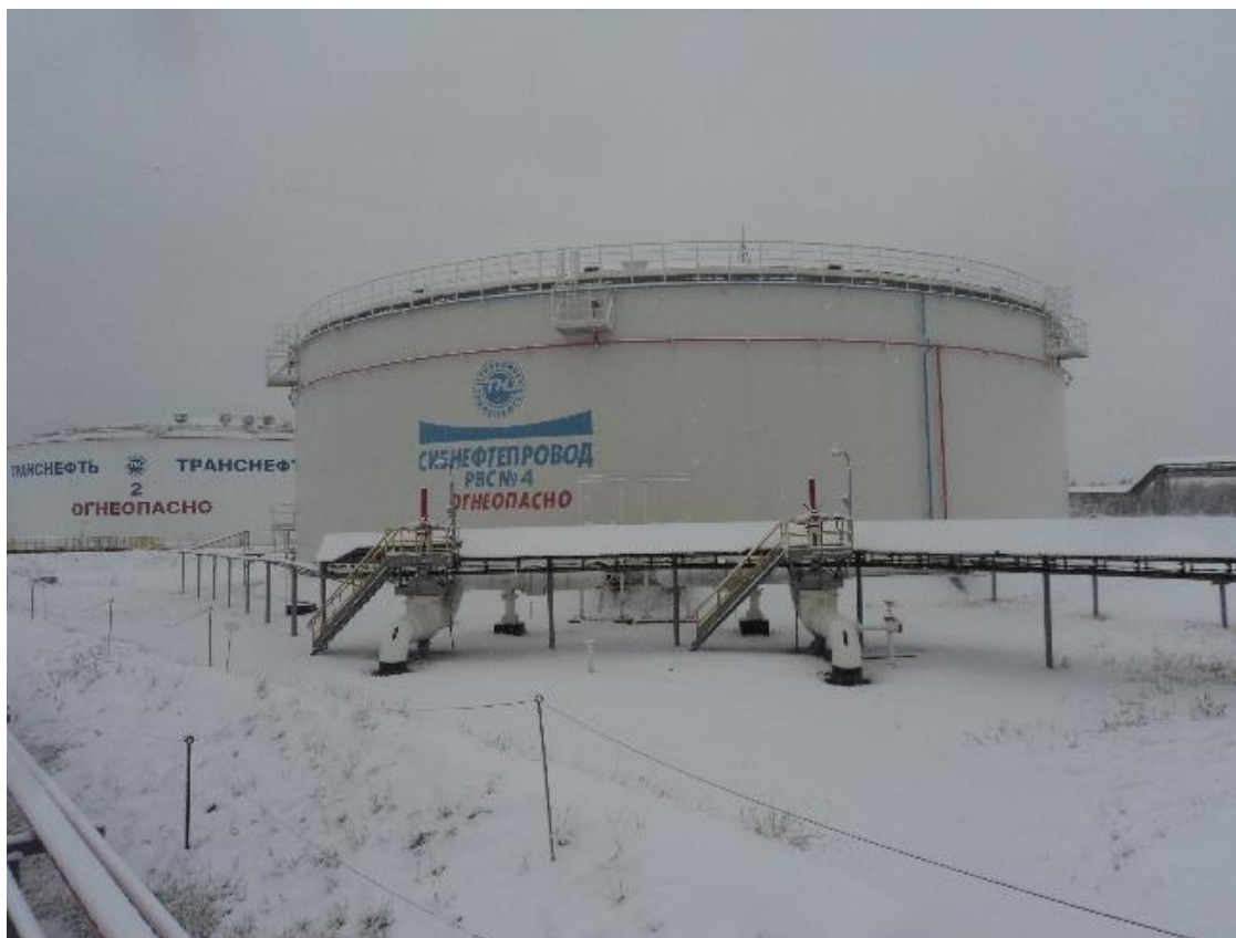
Рисунок 3 - Общий вид резервуара вертикального стального цилиндрического РВСП-20000
