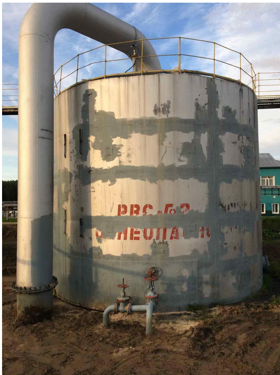
Рисунок 1 - Общий вид резервуара вертикального стального цилиндрического РВС-400
