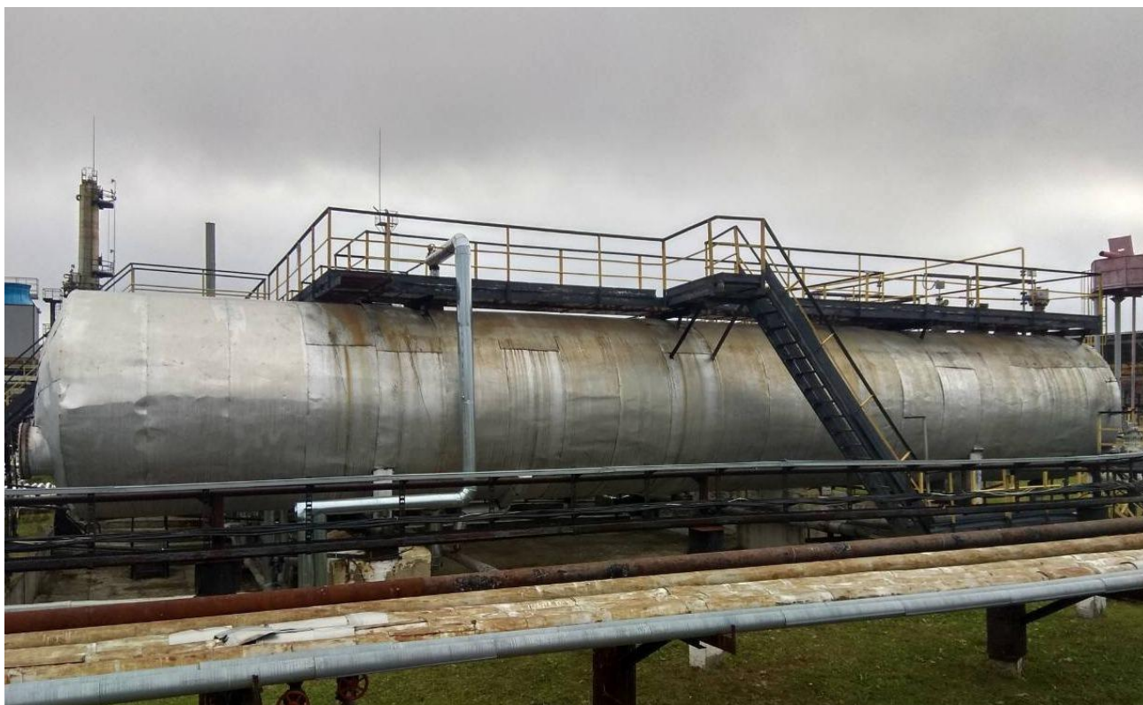
Рисунок 1 - Общий вид резервуара стального горизонтального цилиндрического РГС-200
