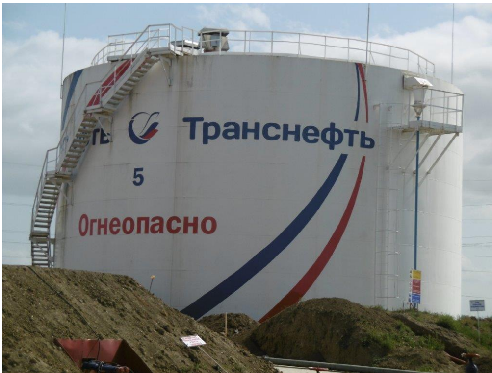
Рисунок 1 - Общий вид резервуара вертикального стального цилиндрического РВС-3000
