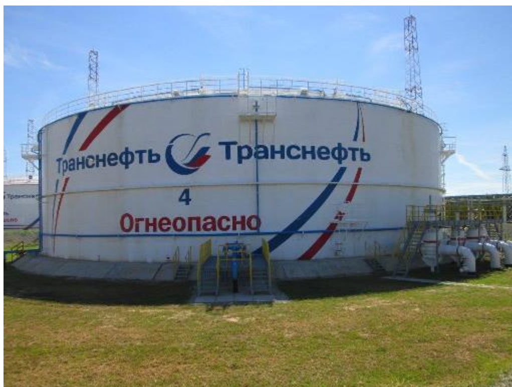
Рисунок 2 - Общий вид резервуара вертикального стального цилиндрического RVSP-20000
