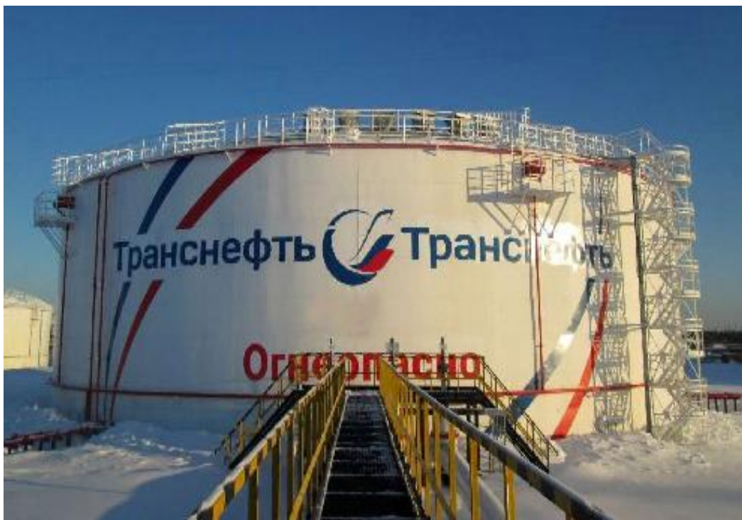
Рисунок 1 - Общий вид резервуара вертикального стального цилиндрического РВС-20000
