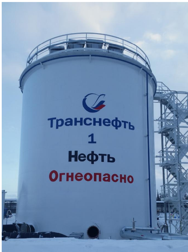
Рисунок 1 - Общий вид резервуаров вертикальных стальных цилиндрических РВС-1000
