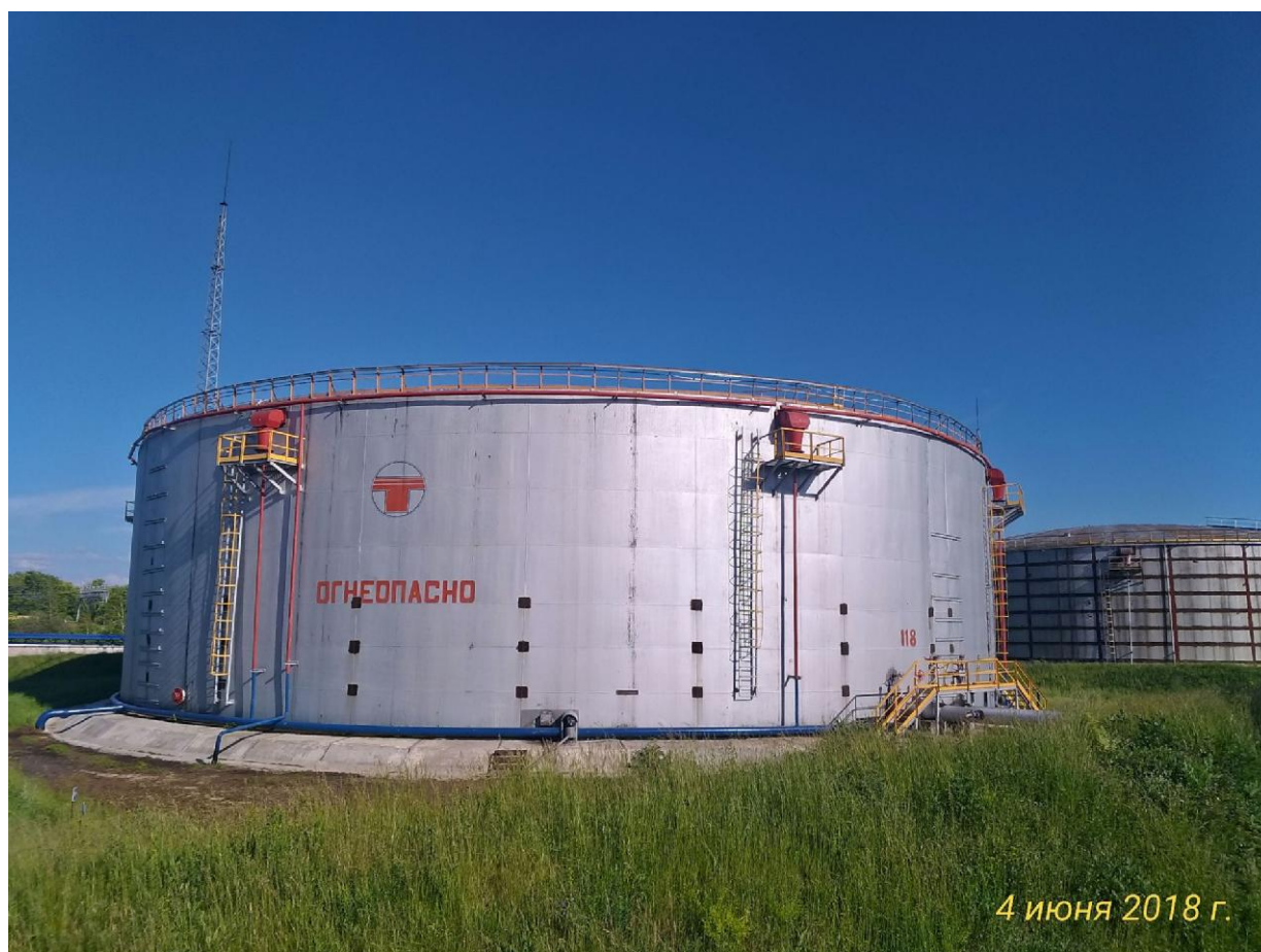
Рисунок 2 - Общий вид резервуара вертикального стального цилиндрического РВС-20000
