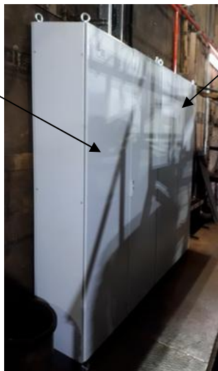
Рисунок 3 – Шкаф приборный измерения давлений № 1 и шкаф сканеров температур. Вид внешний
