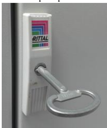
Рисунок 17 – Замок и ключ шкафа кроссового. Вид внешний
