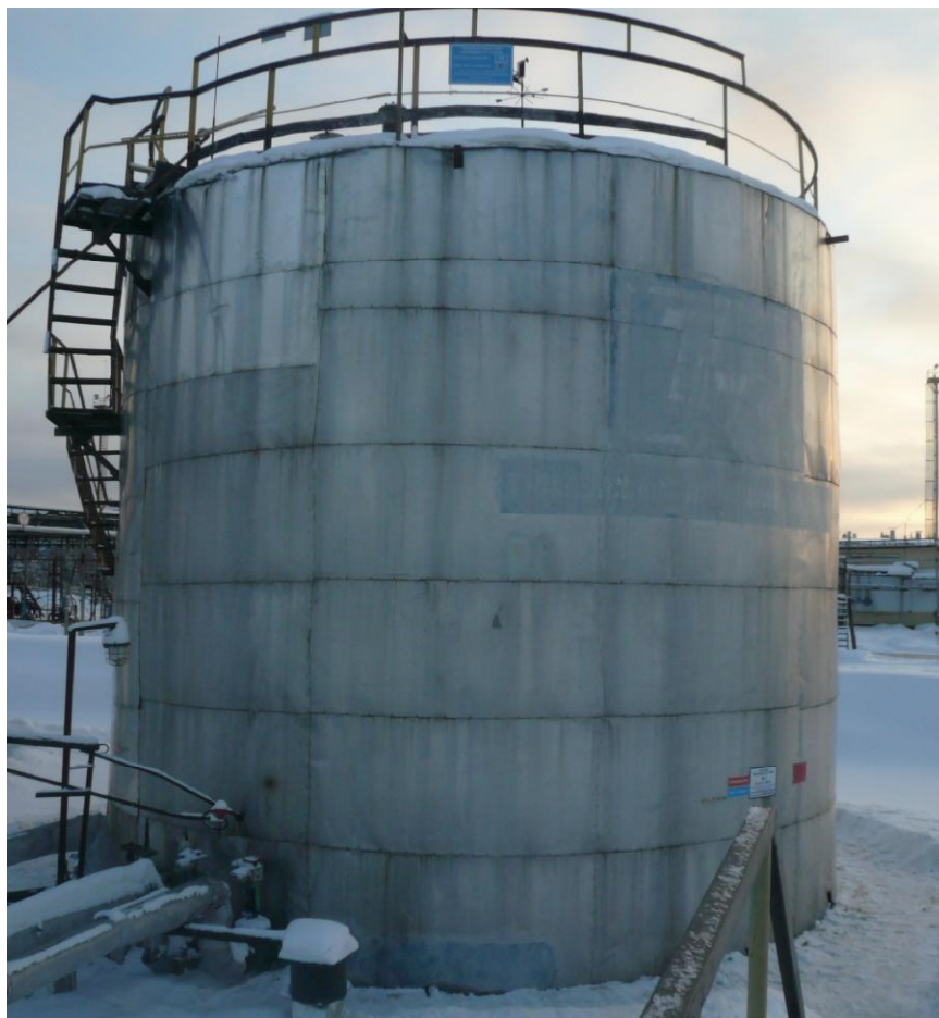
Рисунок 1 - Общий вид резервуара стального вертикального цилиндрического РВС-400
