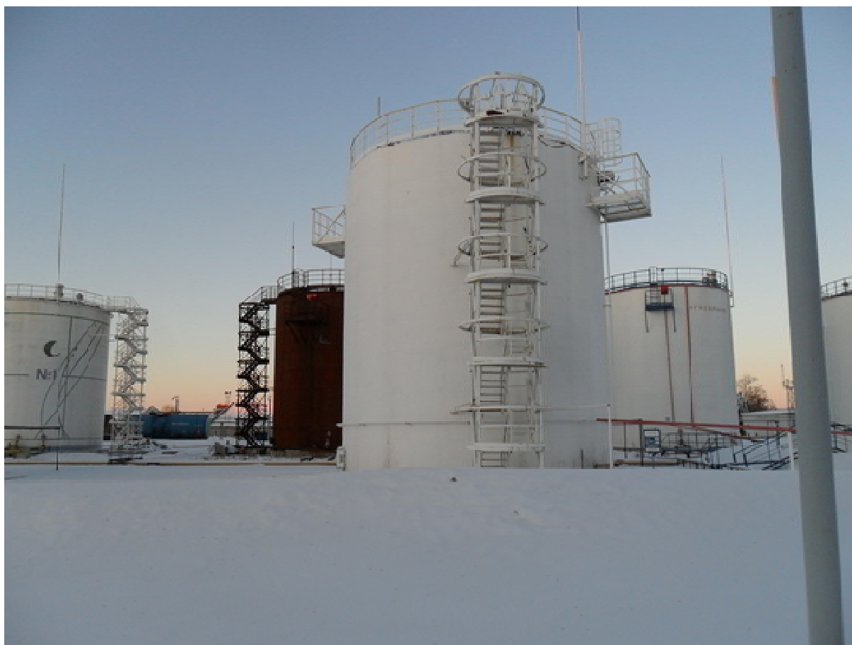
Рисунок 1 - Общий вид резервуара вертикального стального цилиндрического РВС-1000
