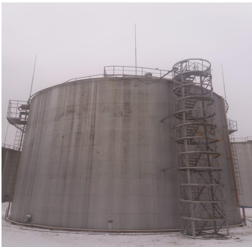
Рисунок 4 - Общий вид резервуара вертикального стального цилиндрического РВСП-5000
