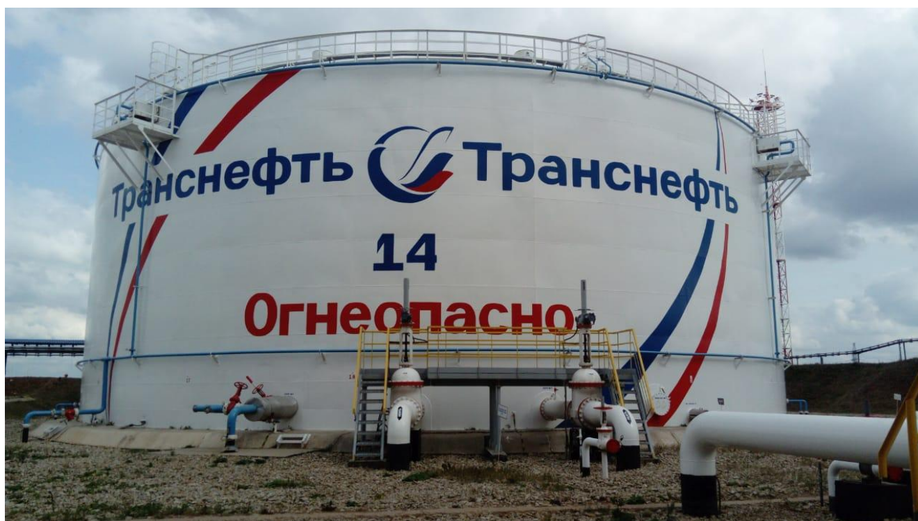
Рисунок 1 - Общий вид резервуара вертикального стального цилиндрического РВСП-10000
