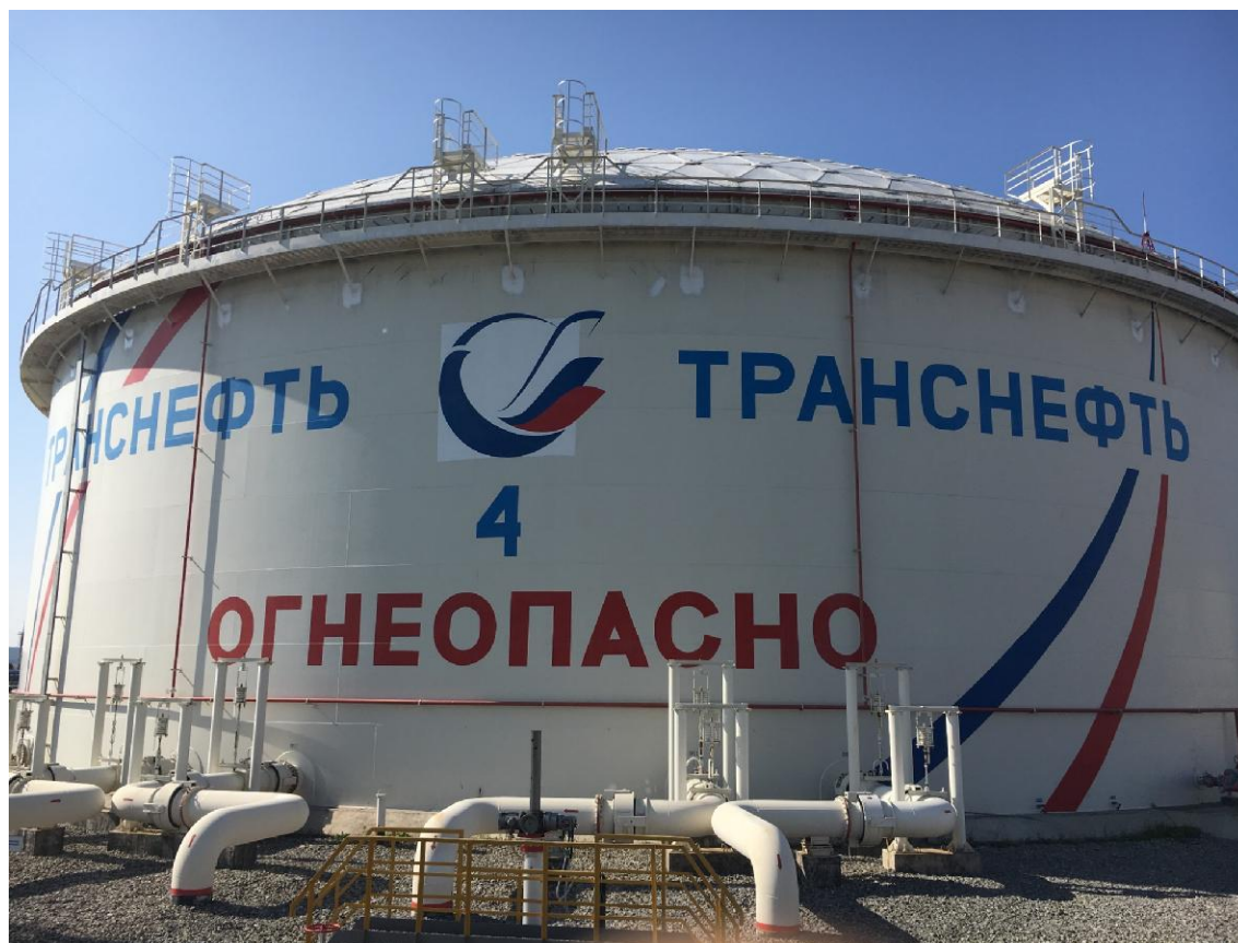
Рисунок 3 - Общий вид резервуара вертикального стального цилиндрического РВСПА-50000
