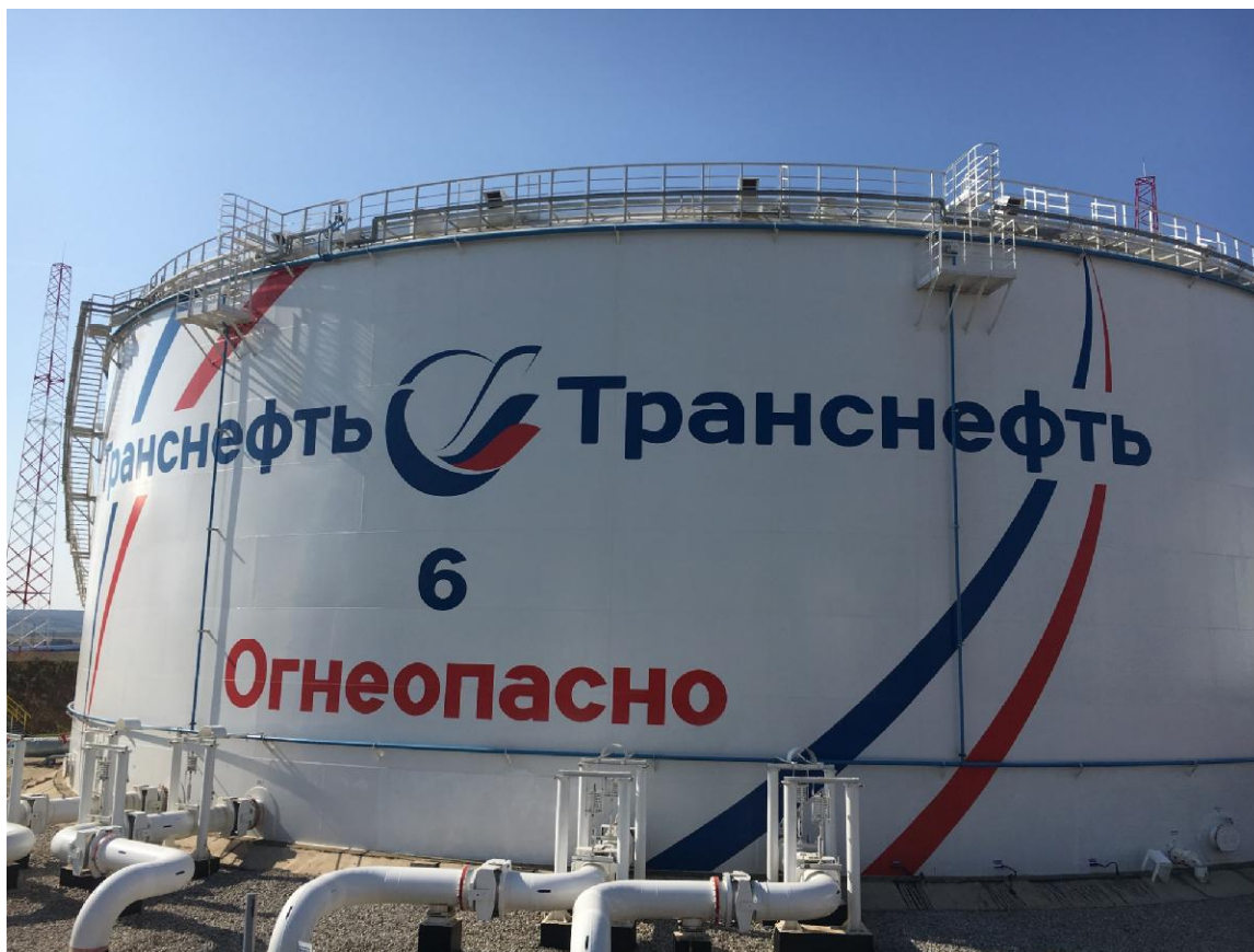
Рисунок 2 - Общий вид резервуара вертикального стального цилиндрического РВСП-50000
