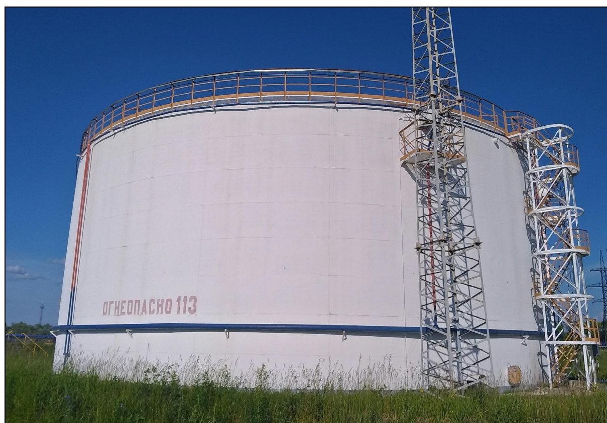
Рисунок 3 - Общий вид резервуаров вертикальных стальных цилиндрических РВС-10000
