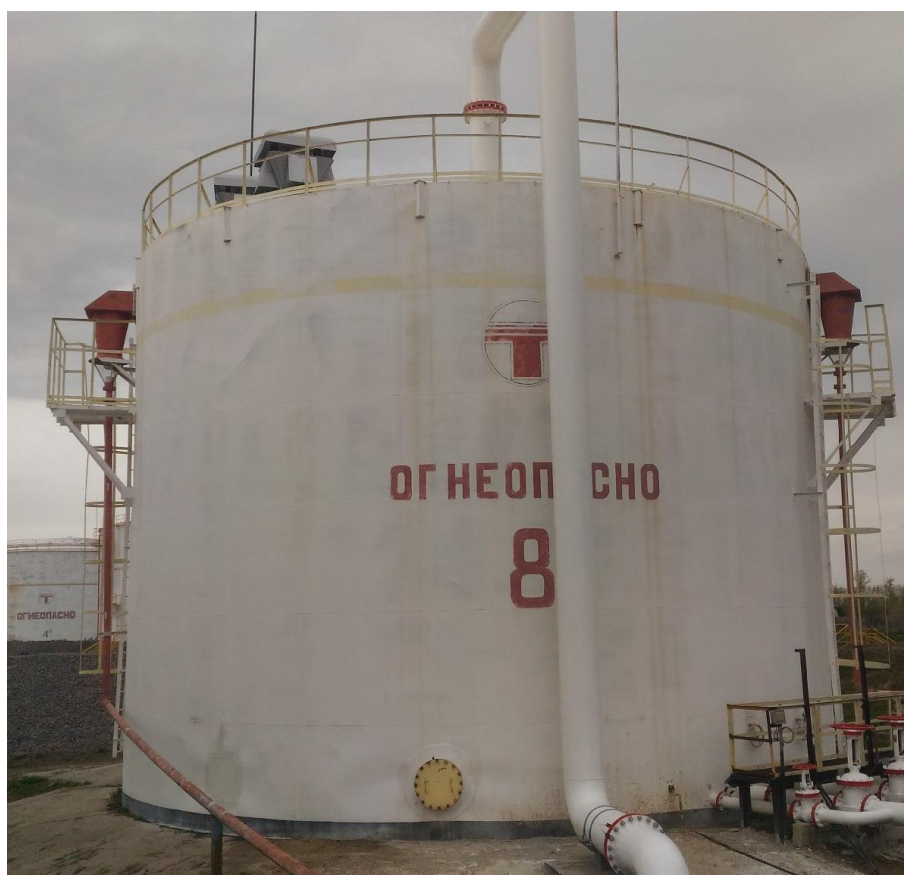
Рисунок 1 - Общий вид резервуаров вертикальных стальных цилиндрических РВС-1000
