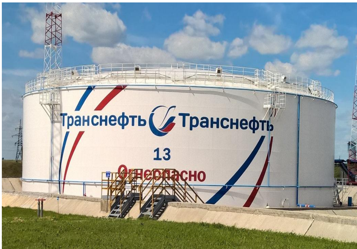
Рисунок 6 - Общий вид резервуаров вертикальных стальных цилиндрических РВСП-20000
