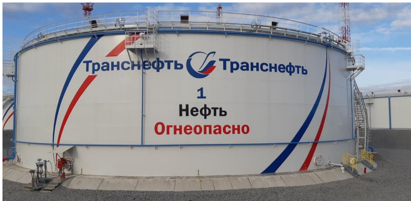
Рисунок 2 - Общий вид резервуара вертикального стального цилиндрического РВСП-20000
