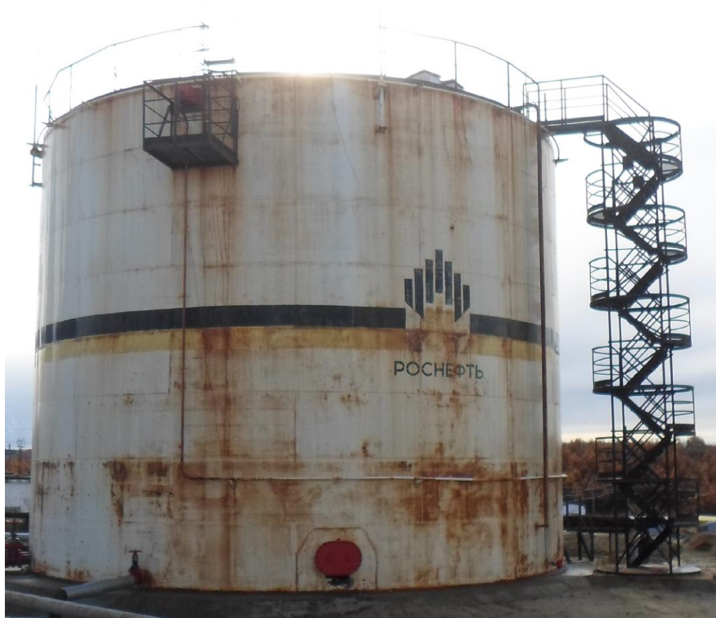
Рисунок 1 - Общий вид резервуара стального вертикального цилиндрического РВС-2000
