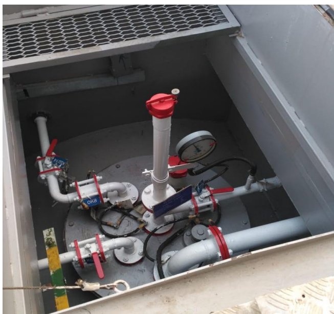
Рисунок 5 - Общий вид видимой части конструкции резервуара РГС-20 № 635
