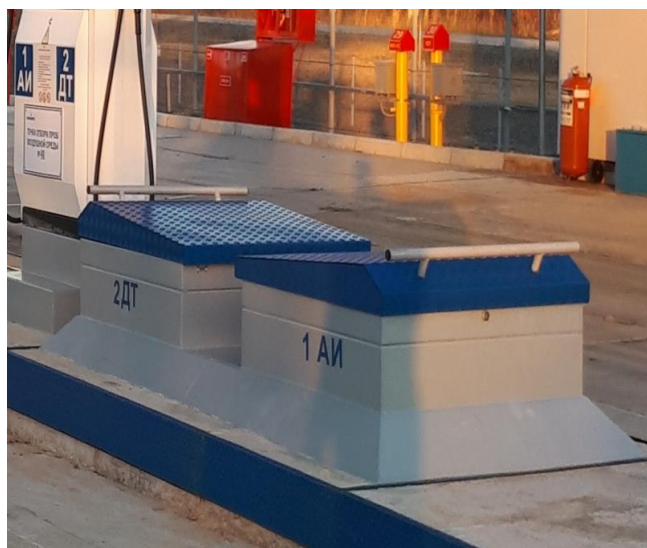
Рисунок 5 - Общий вид видимой части конструкции резервуаров РГС-50 № 3787, 3788
