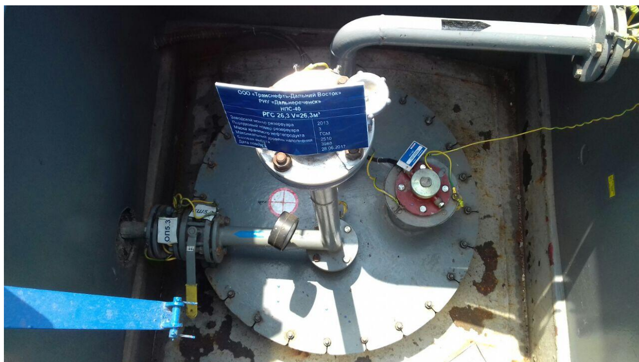
Рисунок 4 - Общий вид видимой части конструкции резервуара РГС-25 № 2013
