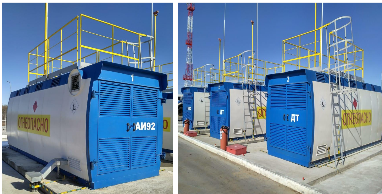
Рисунок 1 - Общий вид резервуаров РГС-20 №№ 4065, 4066, 4067
