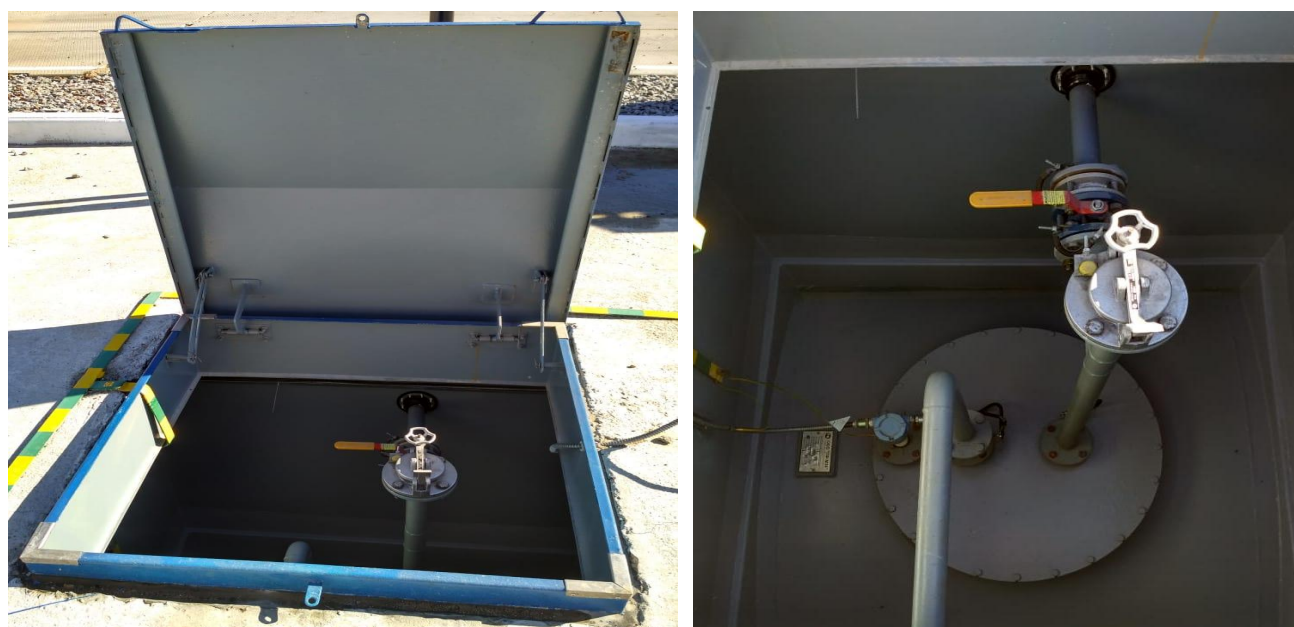
Рисунок 2 - Общий вид видимой части конструкции резервуара РГС-25 № 4068
