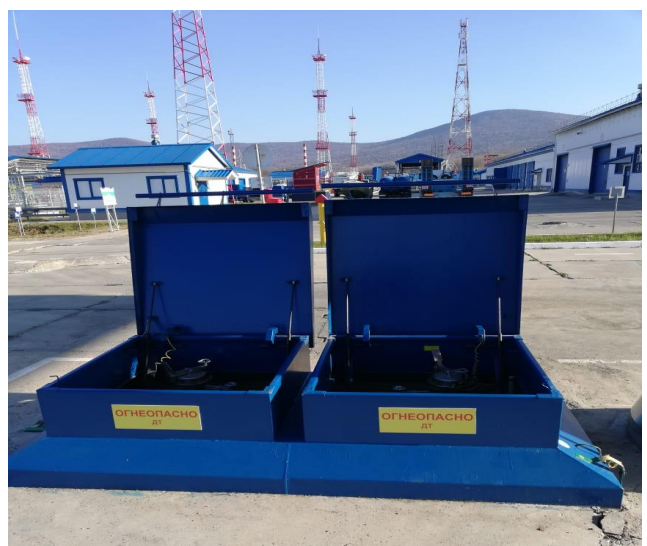
Рисунок 6 - Общий вид видимой части конструкции резервуаров РГС-50 № 2011, 2012
