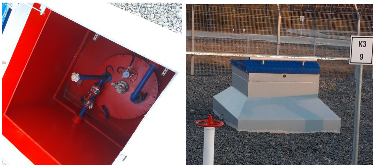
Рисунок 3 - Общий вид видимой части конструкции резервуара РГС-25 № 3790
