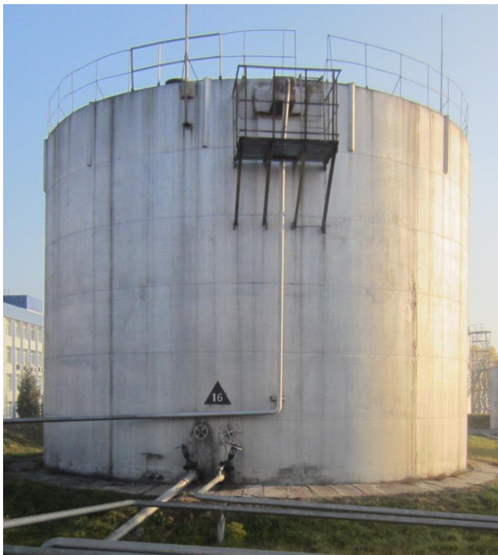
Рисунок 2 - Общий вид резервуара стального вертикального цилиндрического PVC-1000
