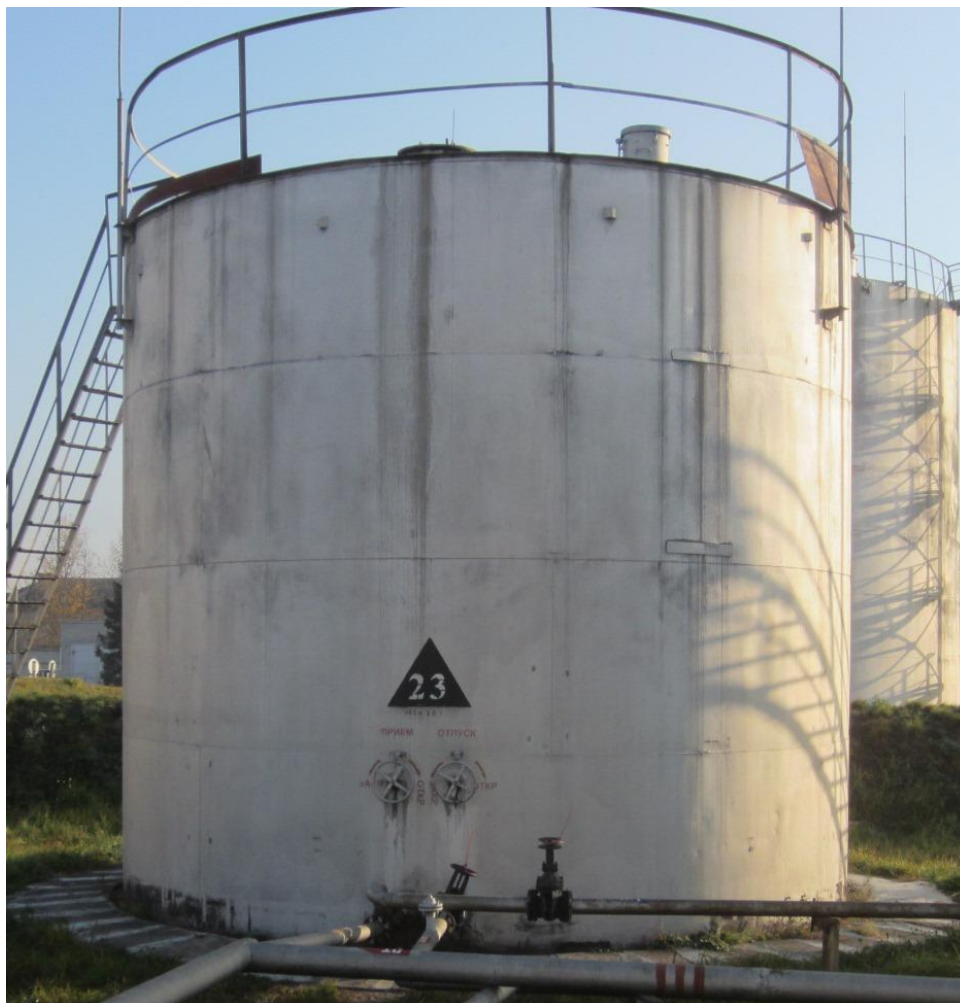
Рисунок 1 - Общий вид резервуара стального вертикального цилиндрического РВС-200
