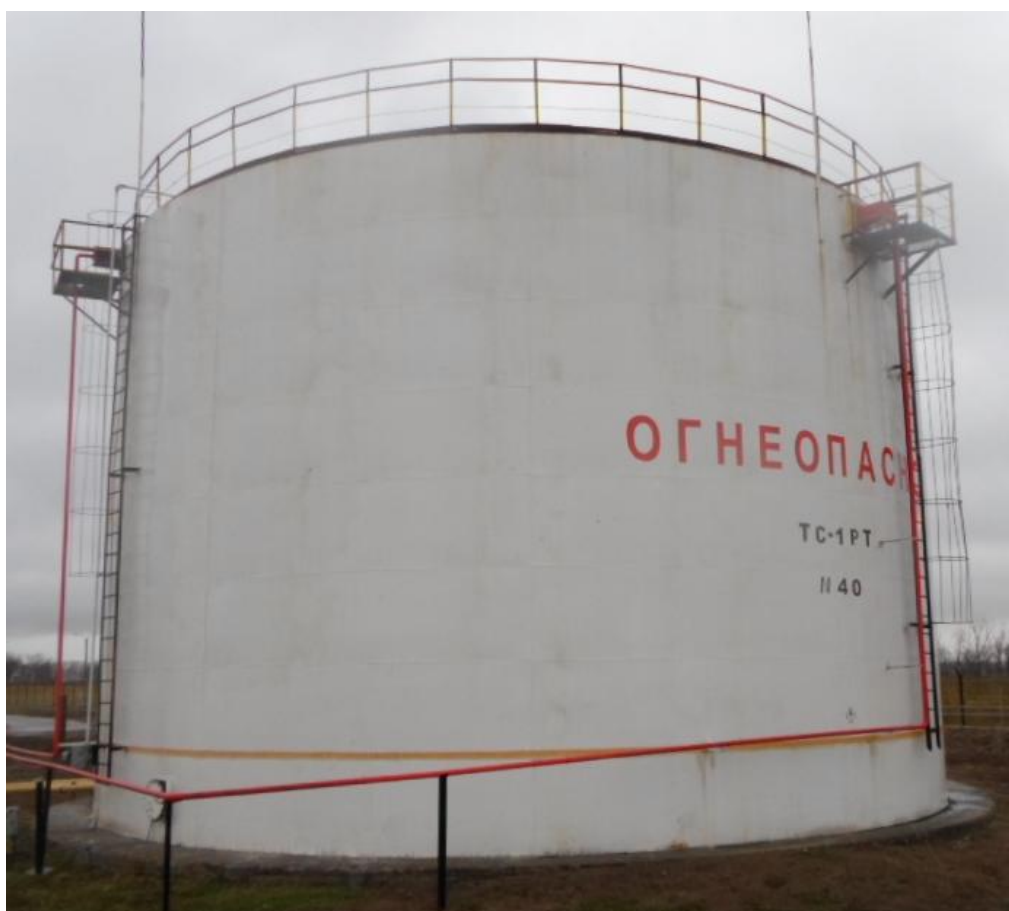
Рисунок 2 - Общий вид резервуара стального вертикального цилиндрического РВС-3000
