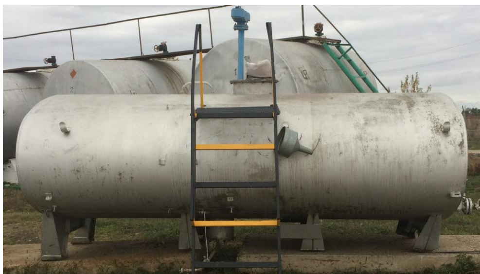
Рисунок 3 - Общий вид резервуара стального горизонтального цилиндрического РГС-8
