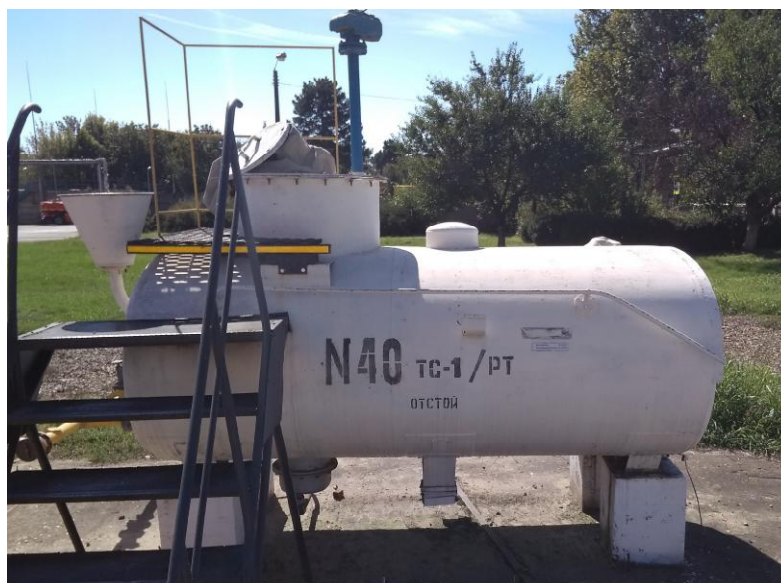
Рисунок 1 - Общий вид резервуара стального горизонтального цилиндрического РГС-3
