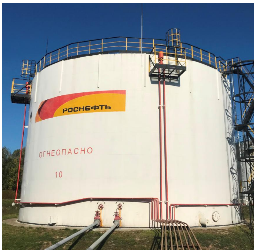
Рисунок 7 - Общий вид резервуара стального вертикального цилиндрического РВСП-3000
