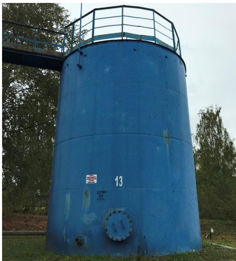
Рисунок 1 - Общий вид резервуара стального вертикального цилиндрического РВС-100
