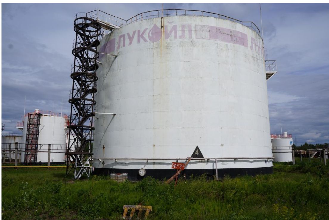
Рисунок 1 - Общий вид резервуара стального вертикального цилиндрического РВС-5000
