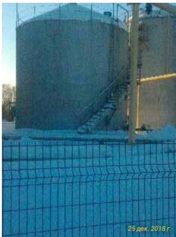
Рисунок 1 - Общий вид резервуара вертикального стального цилиндрического РВС-400
