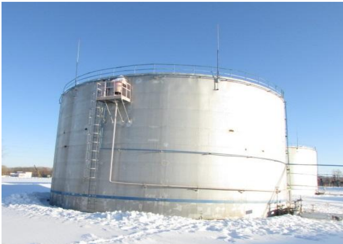
Рисунок 1 - Общий вид резервуара вертикального стального цилиндрического РВС-5000
