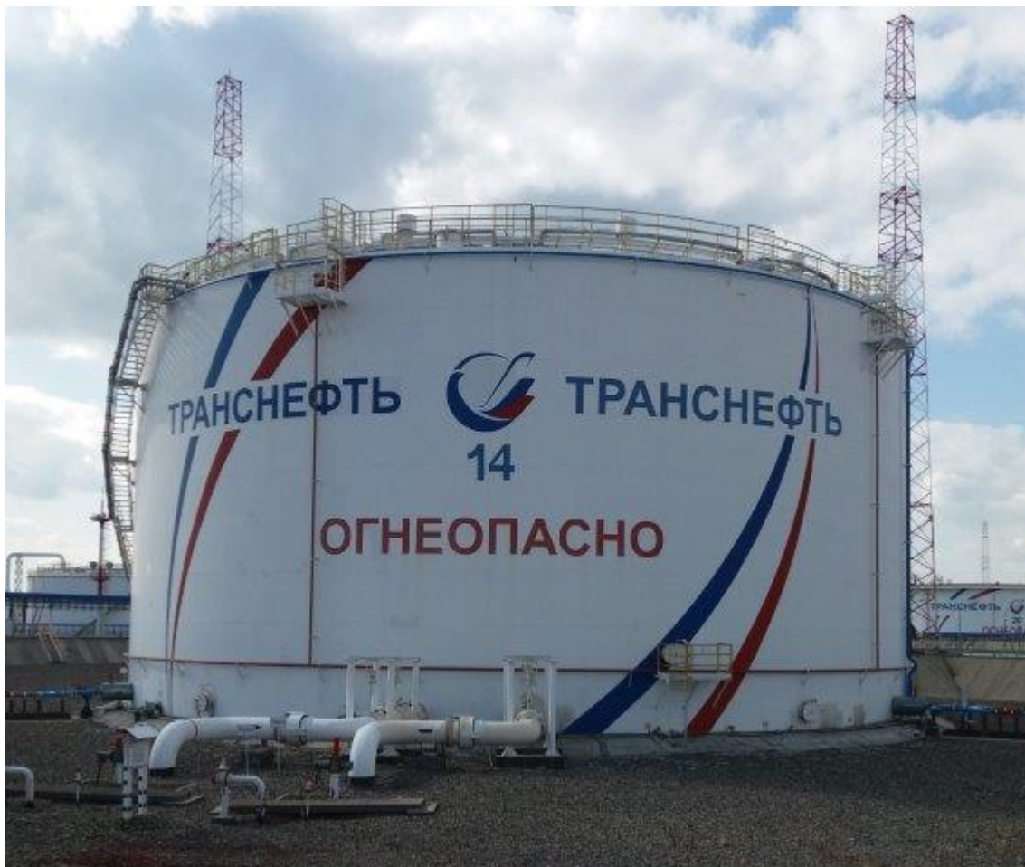
Рисунок 2 - Общий вид резервуара вертикального стального цилиндрического РВСП-20000
