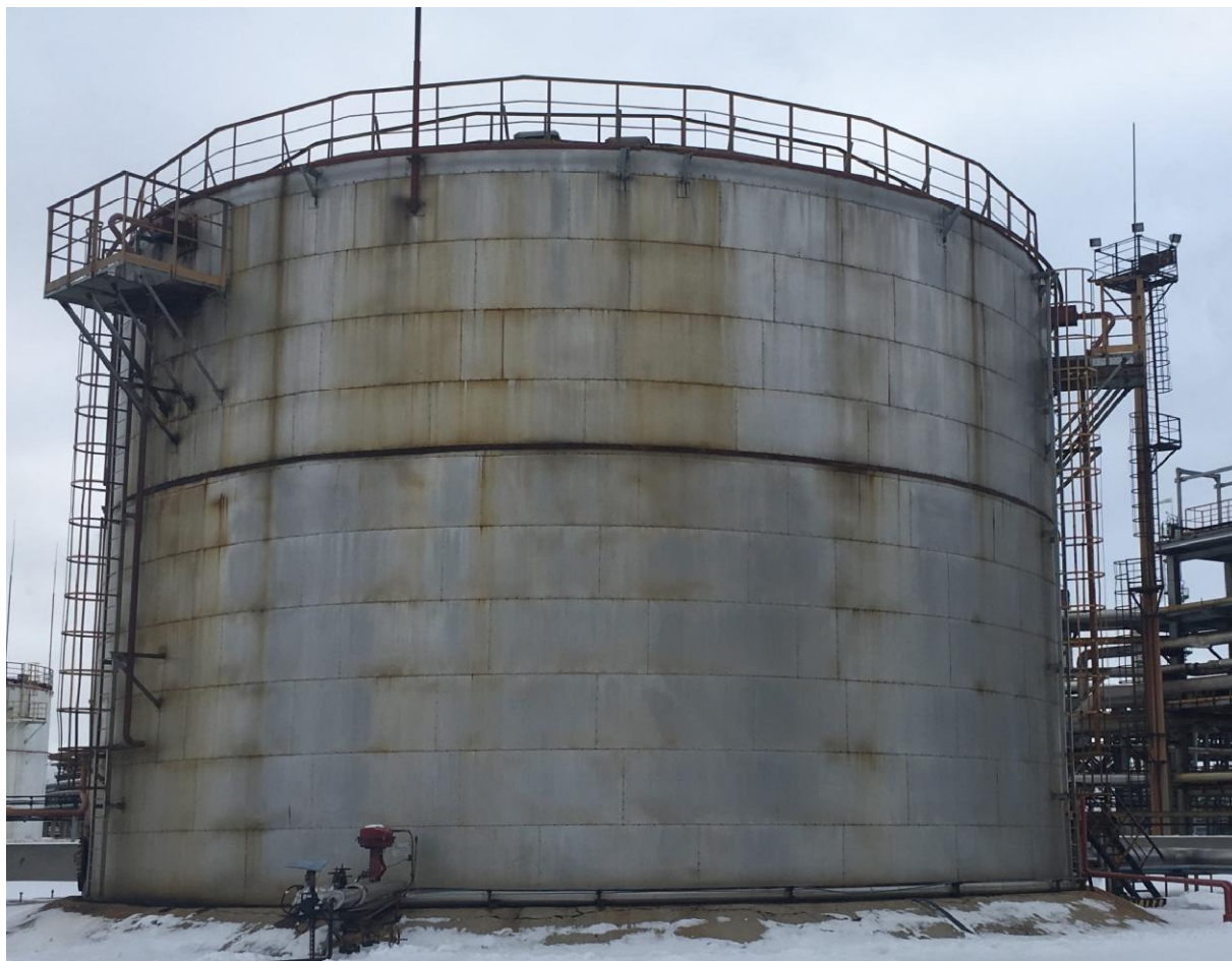
Рисунок 1 - Общий вид резервуара стального вертикального цилиндрического РВС-3000
