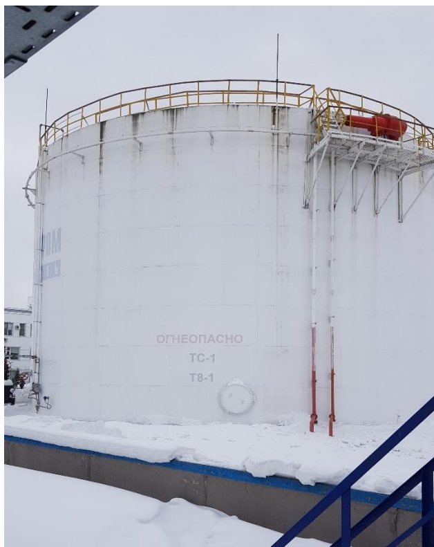
Рисунок 5 - Общий вид резервуаров РВС-3000 №№ Т8-1, Т8-2
