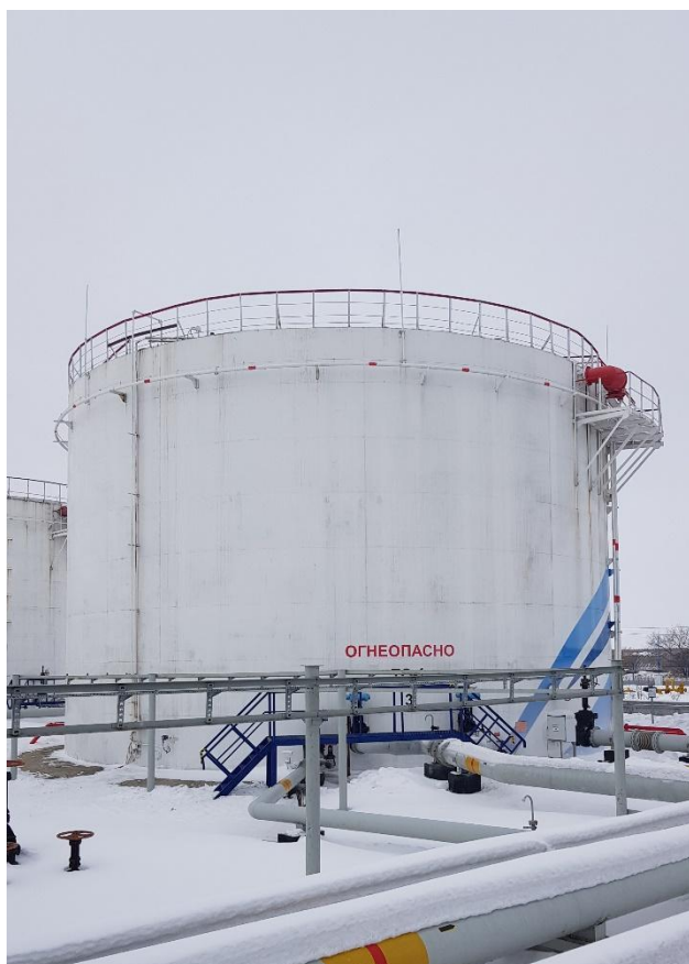
Рисунок 4 - Общий вид резервуаров РВС-3000 №№ Т1-3, Т1-4
