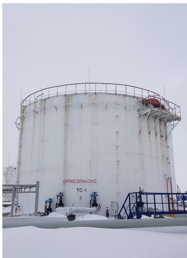
Рисунок 4 - Общий вид резервуаров РВС-3000 №№ Т1-3, Т1-4
